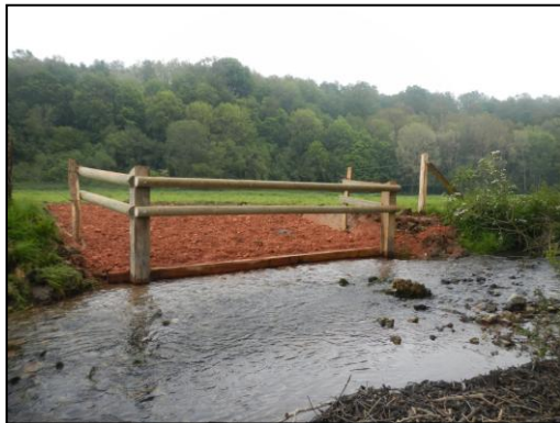
De gauche à droite : Descente classique d'abreuvoir – Création d'un passage à gué permettant le passage et l'abreuvement des bêtes
