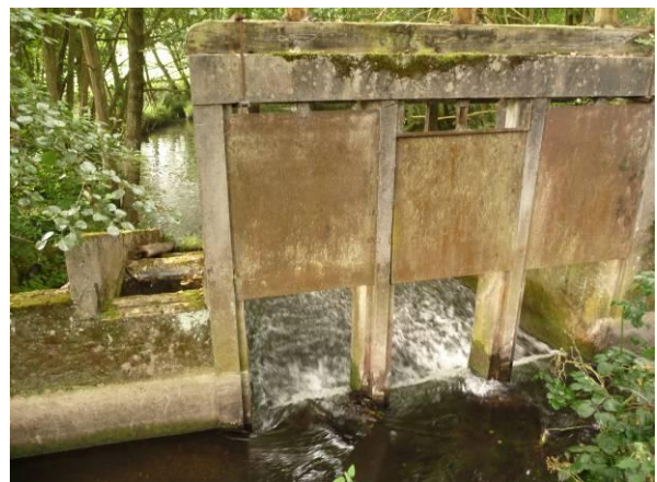
Vue depuis le nord du vannage totalement infranchissable par les espèces piscicoles
